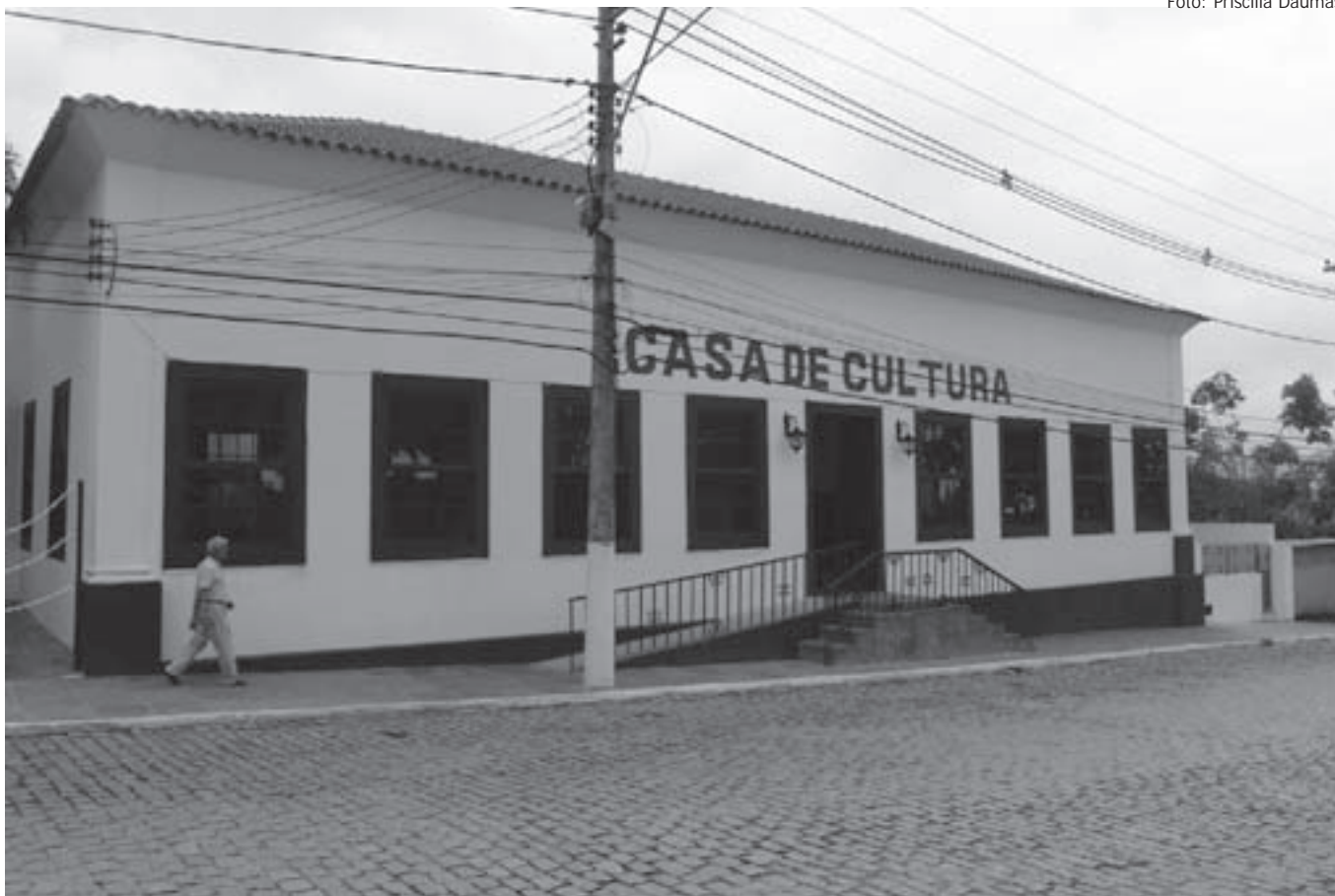
Depois de reforma, a Casa de Cultura de Araruama integra-se ao circuito cultural da Região dos Lagos
