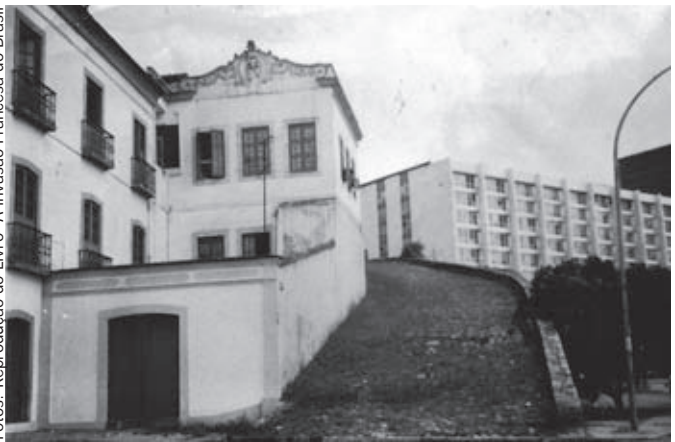
Ladeira da Misericórdia, único trecho do morro do Castelo (Nesse morro ficavam o Colégio e a Igreja dos Jesuítas)
